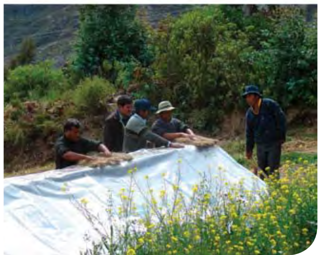
Figura 25: En el caso de altiplano hay que poner la carpa solar. Primero se ponen unos palos enterrados en los tapiales, sobre ellos se echa una capa de barro fresco, encima la carpa y de nuevo barro fresco.
