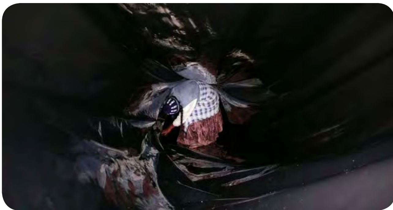
Figura 15: Para hacer la doble capa de plástico es necesario que alguien atraviese toda la manga de plástico arrastrando la otra capa a su interior. En este caso es un ancho de rollo de 1.75 m y es fácil para una persona adulta caminar por dentro.
