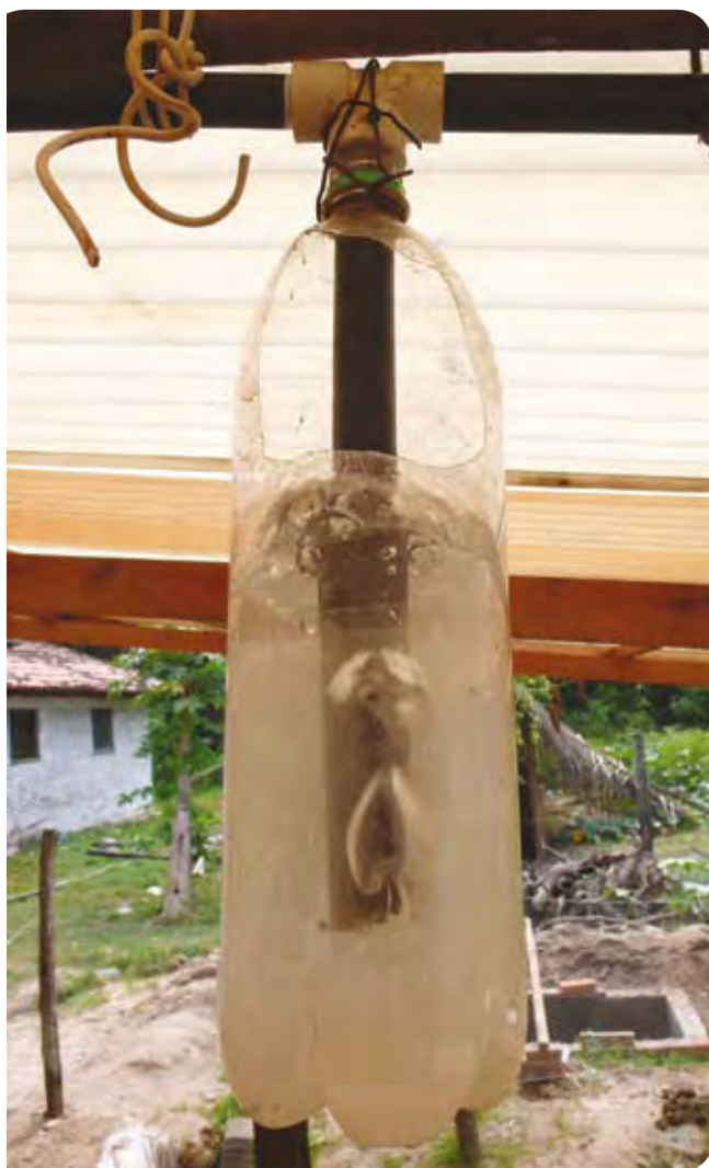
Figura 28: La válvula de seguridad se coloca al principio de la conducción de biogás, cerca del biodigestor, para poder ver todos los días si necesita más agua.
